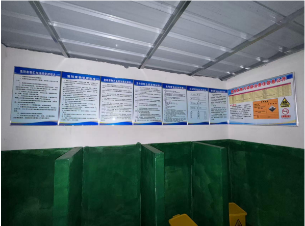
危废暂存间（内部）
