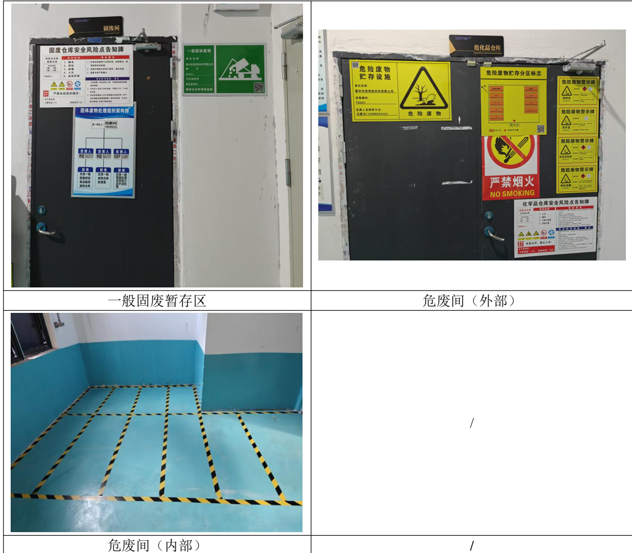
图 4-3 固体废物暂存场所
