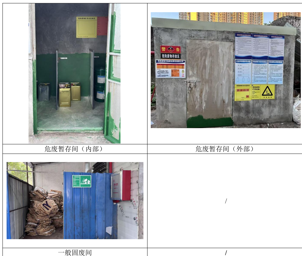
图 4-3 固体废物暂存场所
